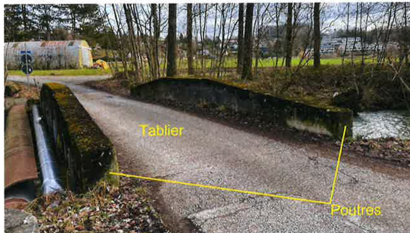
Structure du pont
